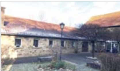
Süddach und Dachrinnen
